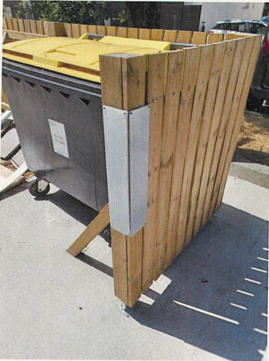
Enclos Habitat 44 : bandes lumineuses pouvant être récupérées (au niveau des accès à l'enclos / pas utile)
